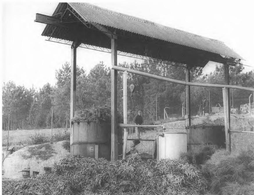
Fig. 14 – Equipamento industrial de destilação por arrastamento com vapor de água (cortesia de Socidestilda).
