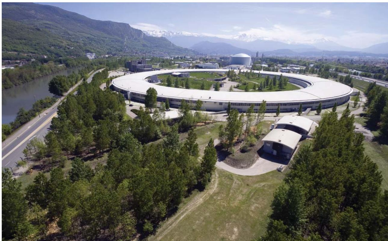
**Figura 2** – Ao contrário de outros aceleradores de partículas, o ESRF não está enterrado e o túnel circular pode distinguir-se perfeitamente [Crédito: A. Petricola, AIR ISERE, ESRF]
